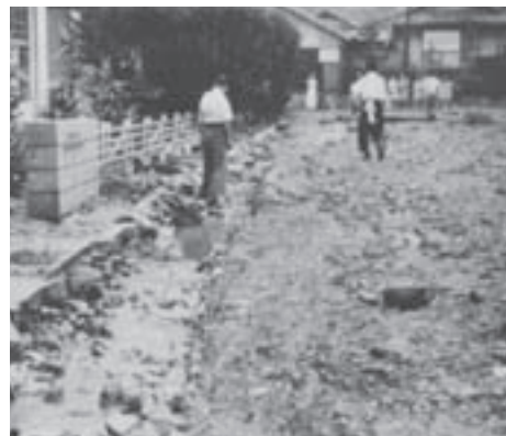
土砂が堆積した道路
