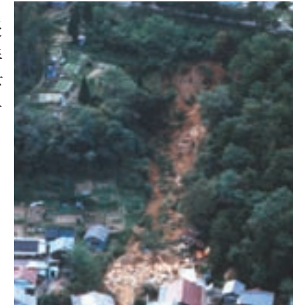
崩壊した斜面(土岐市西山)
