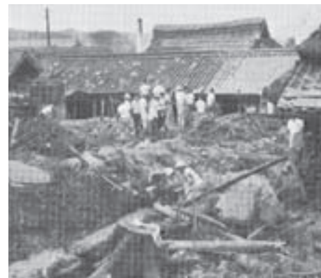
崩壊土砂が押し寄せた集落
