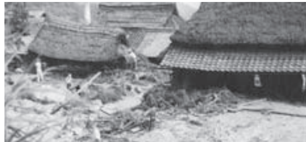
土砂流出により埋まった家屋
