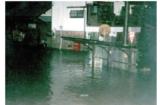
土岐市内の浸水状況
