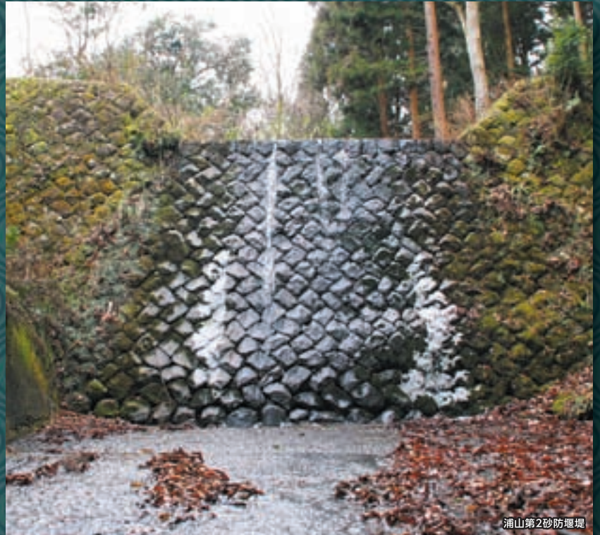
浦山第2砂防堰堤
