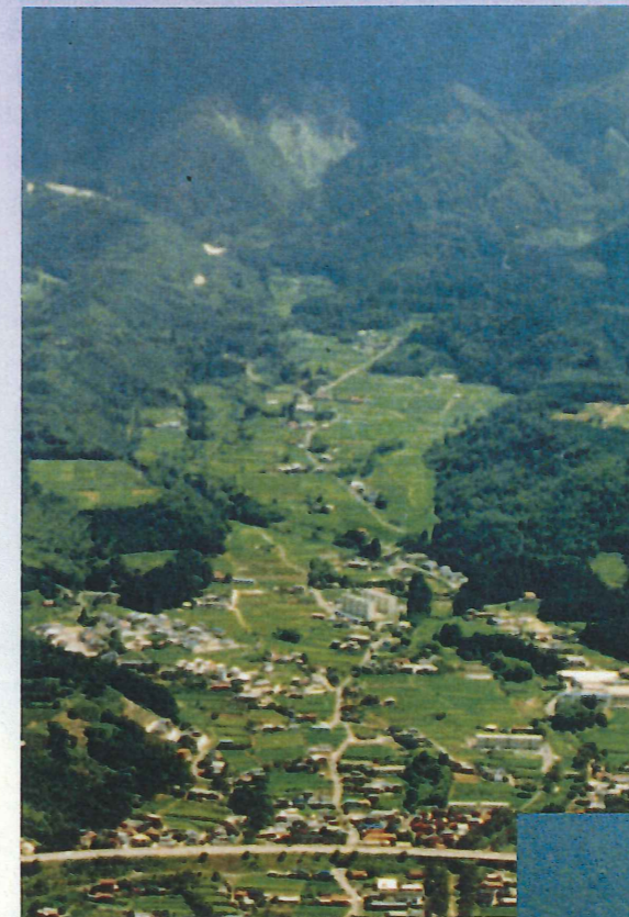
▲「四ツ目川遊砂工」着工前 (昭和55年撮影)
