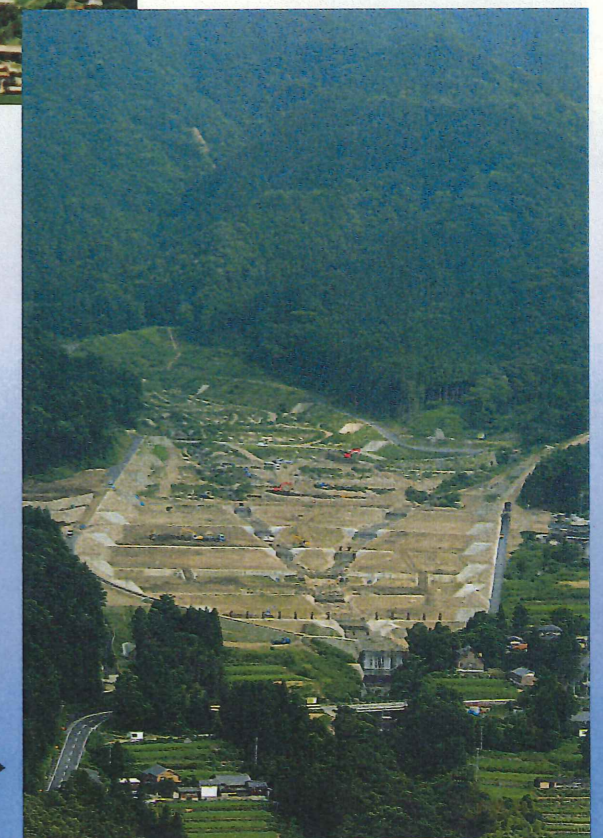
▶「四ツ目川遊砂工」完成後 (平成15年7月撮影)
