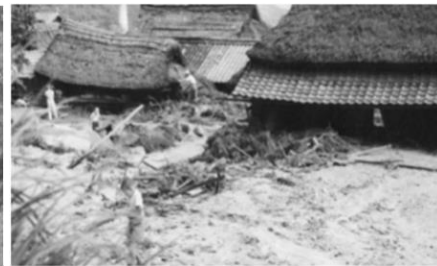
土砂流出により埋まった家屋
