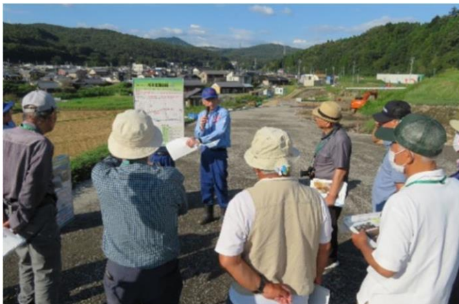
道路工事現場見学(瑞浪恵那道路)
