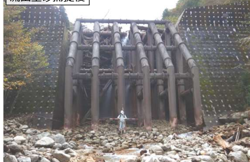
地獄谷第4砂防堰堤（中津川市）
