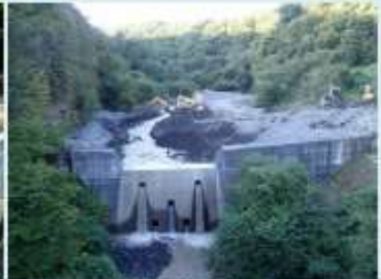
砂防堰堤の除石 (湯川、長野県)
