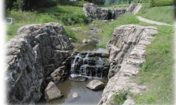
雲五川床固工群 (流路工) [土岐市]
