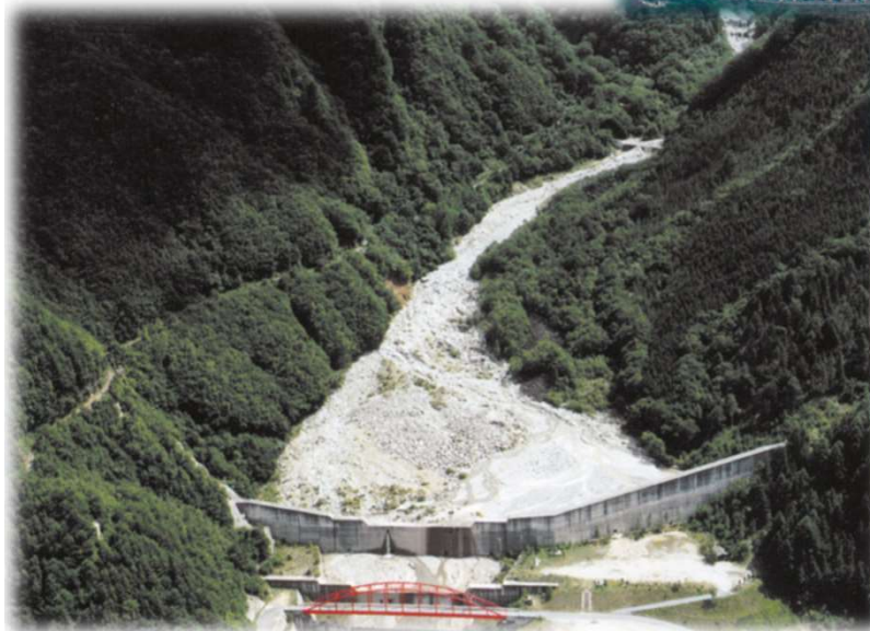
滑川第1砂防堰堤〔上松町〕
