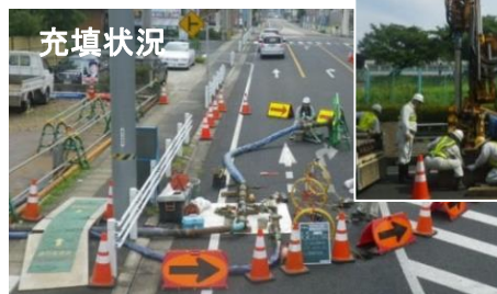
亜炭坑充填工事の様子
