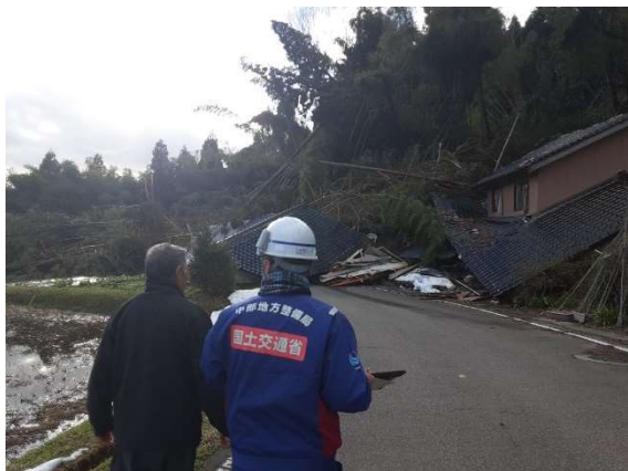
地元の方への被害状況聞き取り
