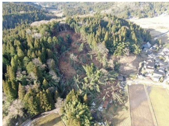
UAVによる被害状況調査
