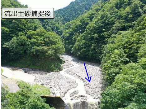
本谷第1砂防堰堤（中津川市）
