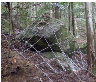
落石防止網(ロープ伏)工
