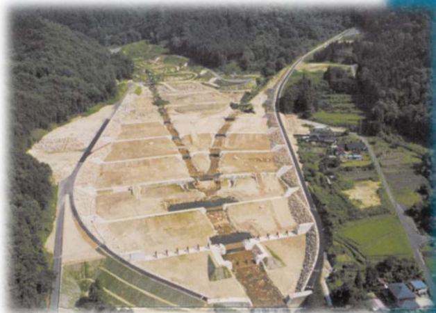
四ッ目川遊砂工〔中津川市〕
