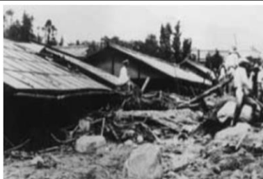
中津川市内の被災状況
