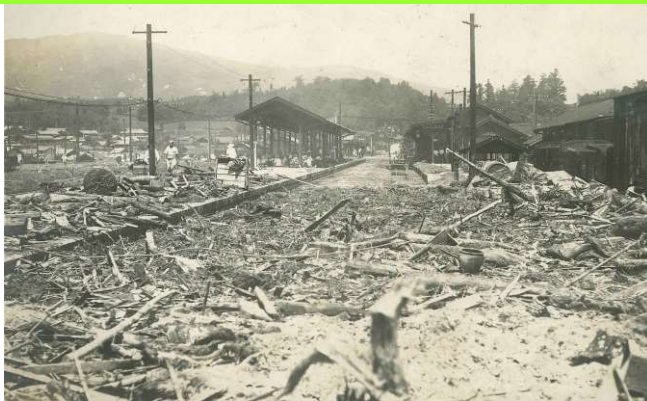
四ッ目川災害(中津川駅構内)
