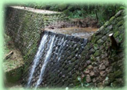
浦山第2砂防堰堤
