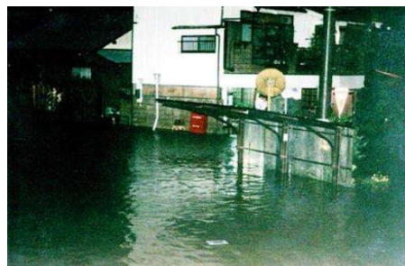
土岐市内の浸水状況
