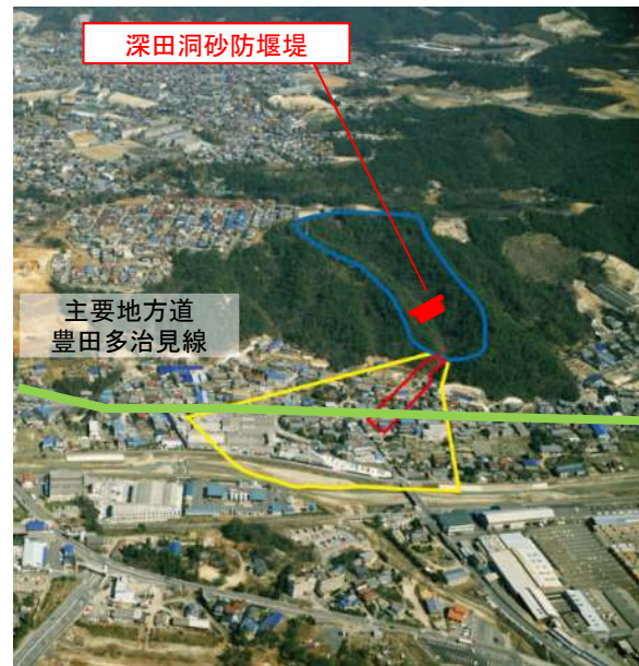
4. 深田洞砂防堰堤（多治見市）
