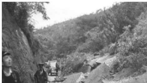
通行止めになった県道
