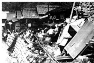
土石流に破壊された家屋
