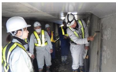
打音検査の実習
