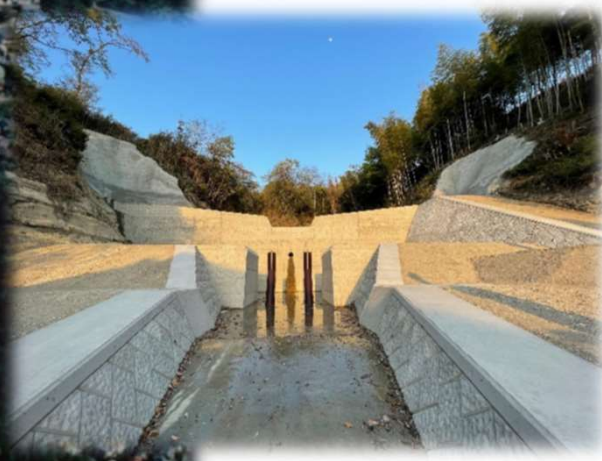
一の洞第2砂防堰堤 [土岐市]
