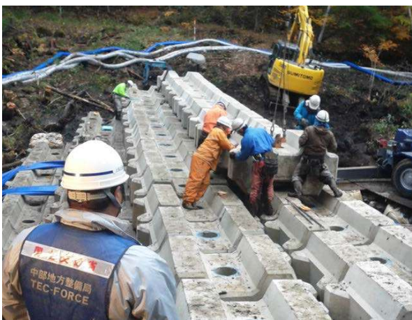
ブロック積み砂防堰堤設置の状況
