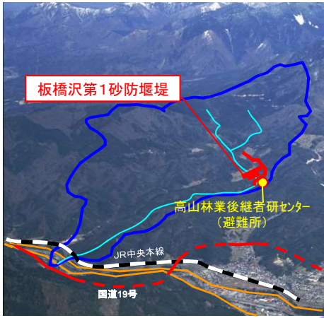
1.板橋沢第1砂防堰堤(上松町)
