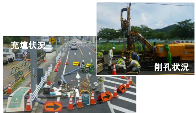
亜炭坑充填工事の様子
