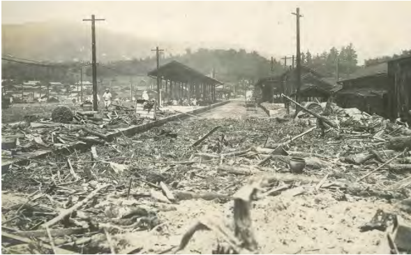
四ツ目川災害(中津川駅構内)
