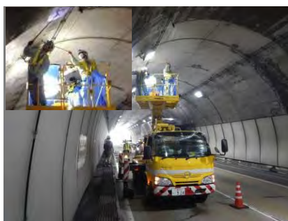
トンネル点検（高所作業車）
