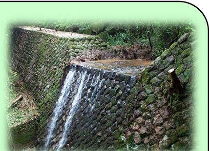
浦山第2砂防堰堤
