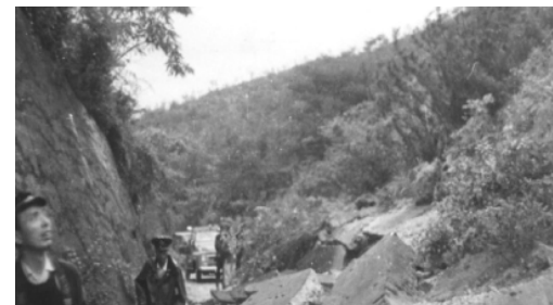
通行止めになった県道
