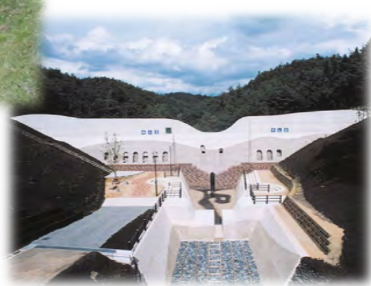
市之倉おりへ砂防堰堤（中峰谷第1砂防堰堤）【多治見市】
