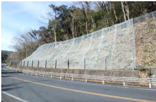
落石防止網工
