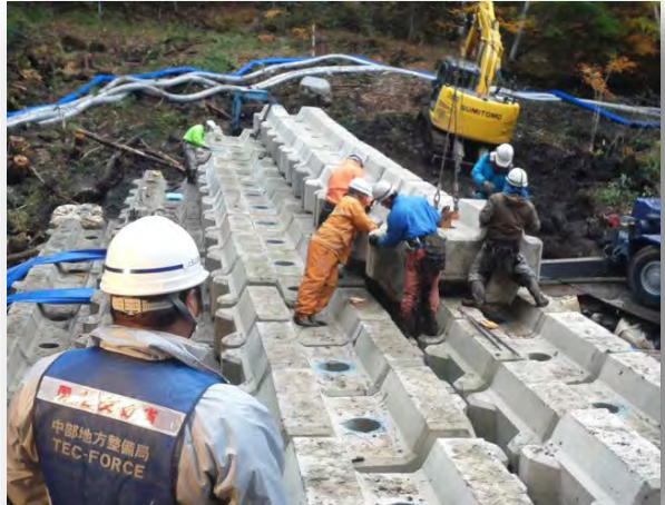
ブロック積み砂防堰堤設置の状況
