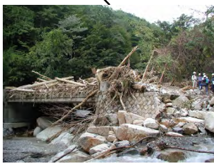
平成12年9月の恵南豪雨時の流木による被災状況（中津川支川一ノ沢）
