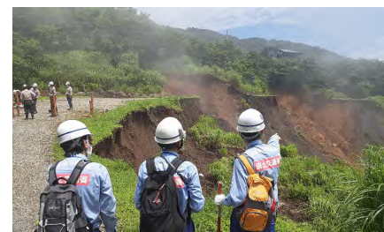
源頭部崩壊箇所調査
