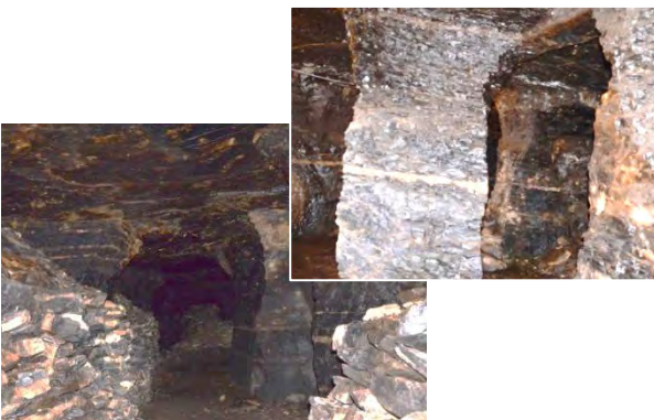
亜炭採掘跡(廃坑内部の様子)
