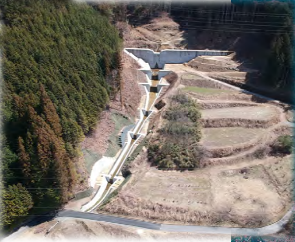
下洞沢砂防堰堤 [大桑村]
