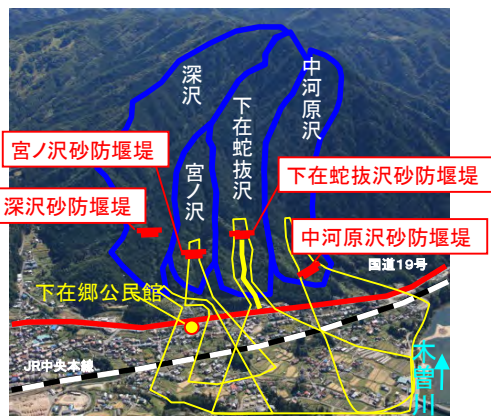
9.下在砂防堰堤工群（大桑村）
