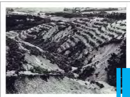
昭和20年代後半山腹工施工(昭和27~28年)
