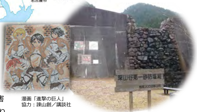
庄内川水系 深山谷第1砂防堰堤【多治見市】
