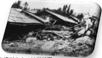
中津川市内の被災状況
