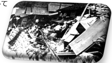
土石流に破壊された家屋
