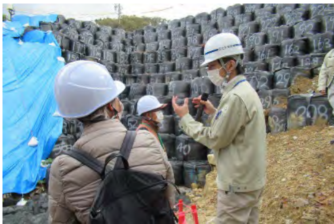
道路工事現場見学(中津川市落合)
