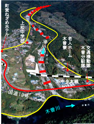
4.滑川下流床固工群（上松町）
