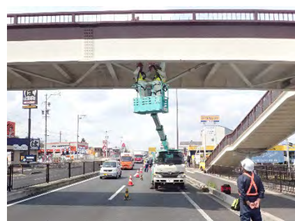
歩道橋点検（高所作業車）
