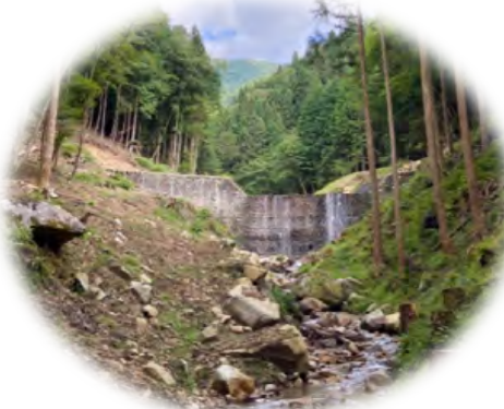
木曽川水系 穴ヶ沢第1砂防堰堤【中津川市】
