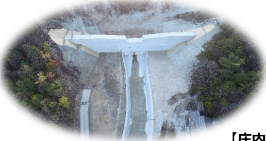
庄内川水系 平園第6砂防堰堤【多治見市】
