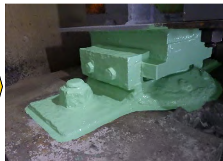
損傷部位の補修
