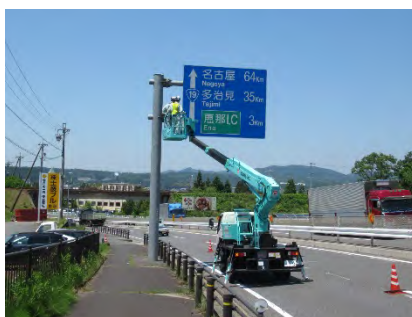
標識点検（高所作業車）
