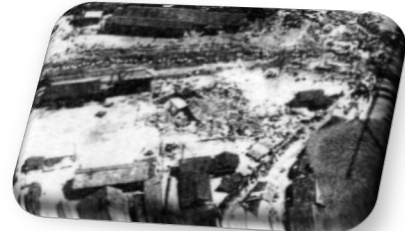
中津川市内の被災状況
