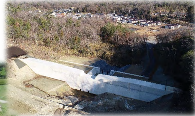
岩山第4砂防堰堤【土岐市】
