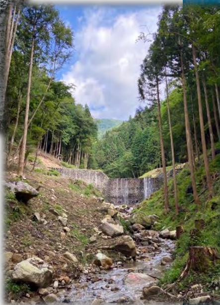
穴ヶ沢第1砂防堰堤（改築）
