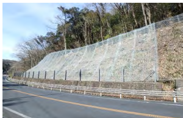
落石防止網工
