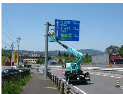
標識点検（高所作業車）
