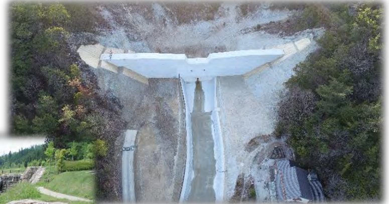
平園第6砂防堰堤
