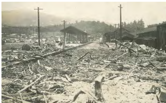
四ツ目川災害(中津川駅構内)
