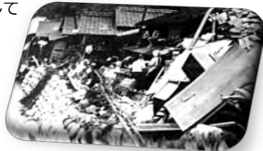
土石流に破壊された家屋
