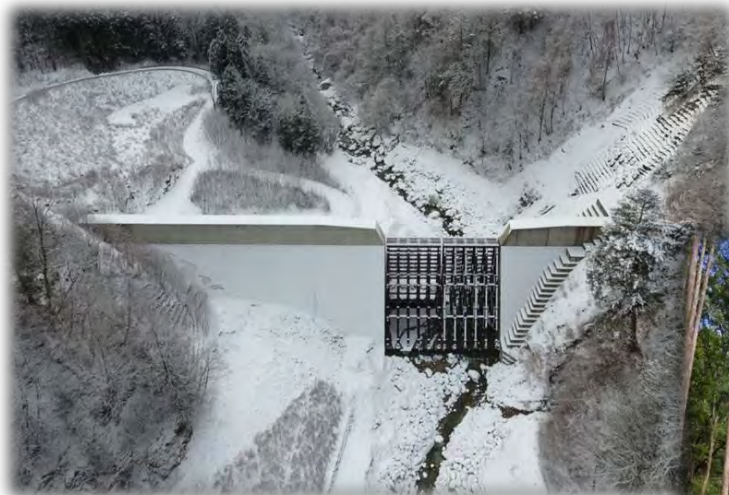
越百川第3砂防堰堤
