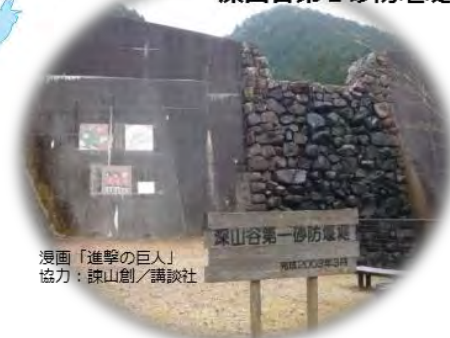
庄内川水系 深山谷第1砂防堰堤
