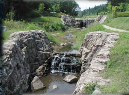
雲五川床固工群（流路工）
