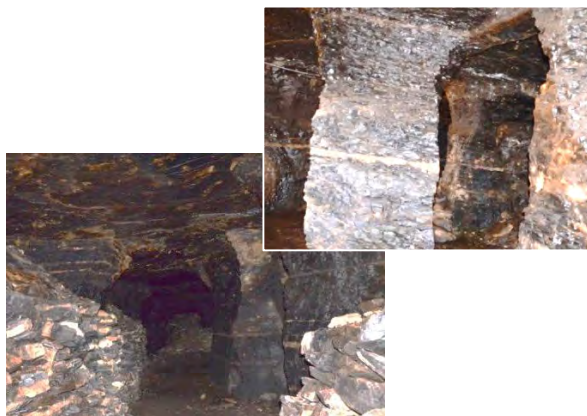
亜炭採掘跡(廃坑内部の様子)
