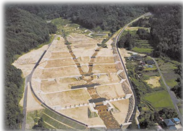
四ッ目川遊砂工
