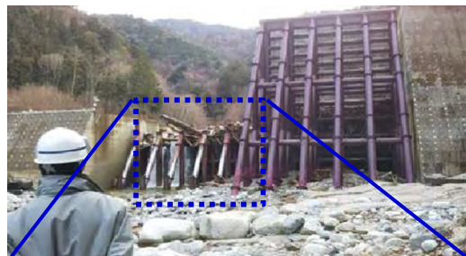
＜整備途中における土砂等の捕捉＞
