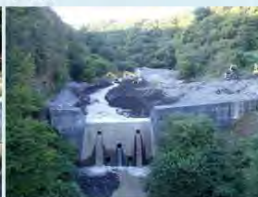
砂防堰堤の除石 (湯川、長野県)
