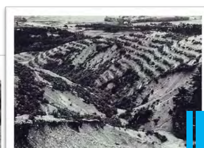
昭和20年代後半 山腹工施工(昭和27～28年)
