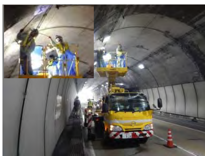
トンネル点検（高所作業車）
