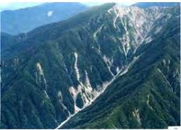
滑川上流の崩壊状況
