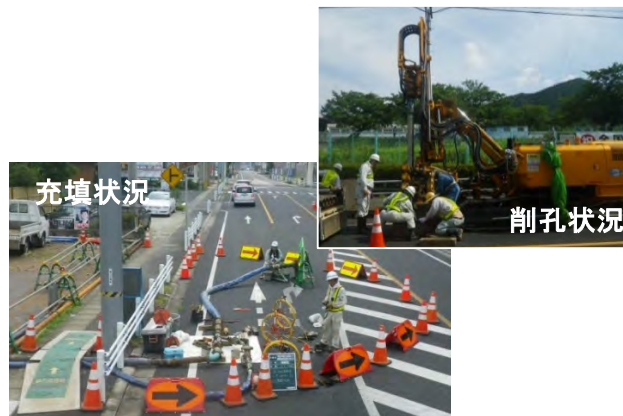
亜炭坑充填工事の様子
