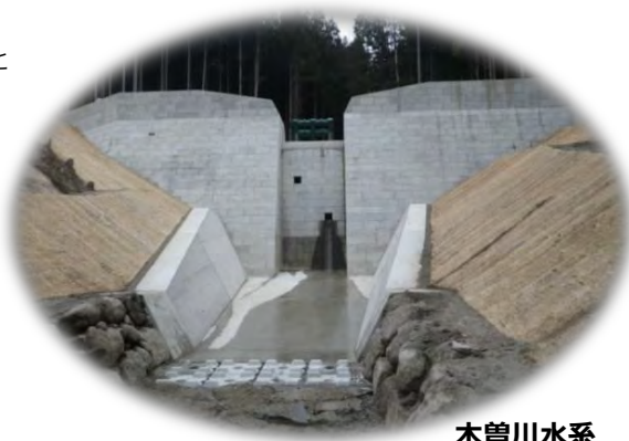
木曽川水系 桜洞砂防堰堤
