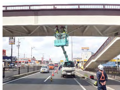
歩道橋点検（高所作業車）
