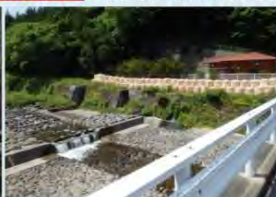
大型土のうによる護岸の高上げ (鈴ヶ沢、長野県)
