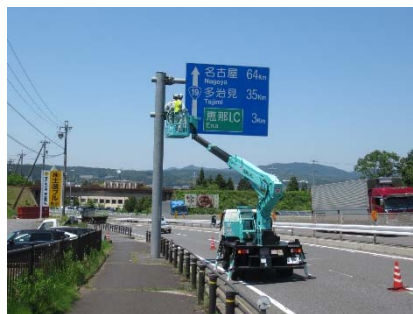
標識点検(高所作業車)
