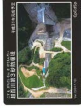
越百川第3砂防堰堤 (長野県木曾郡大森村) 梨子沢第2砂防堰堤
