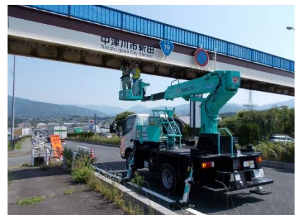
歩道橋点検(高所作業車)
