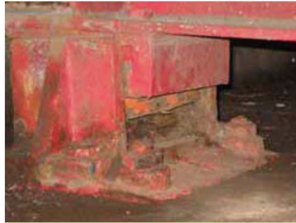
損傷部位の確認
