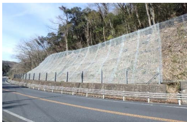
落石防止網工
