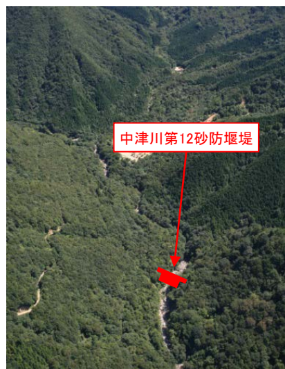
4.中津川第12砂防堰堤 (中津川市)
