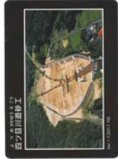
四ツ目川遊砂工 (岐阜県中津川市松田) 梨子沢第2砂防堰堤
