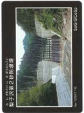
梨子沢第2砂防堰堤 (長野県木曾郡南木曾町) 越百川第3砂防堰堤
