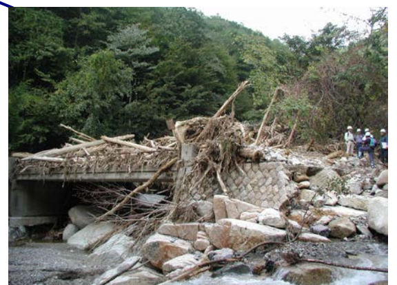
平成12年9月の恵南豪雨時の流木による被災状況(中津川支川一ノ沢)
