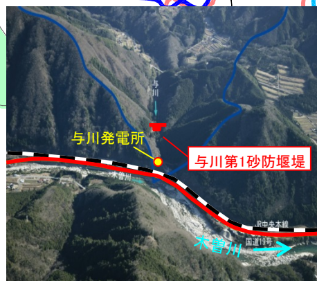
15.与川第1砂防堰堤(南木曾町)
