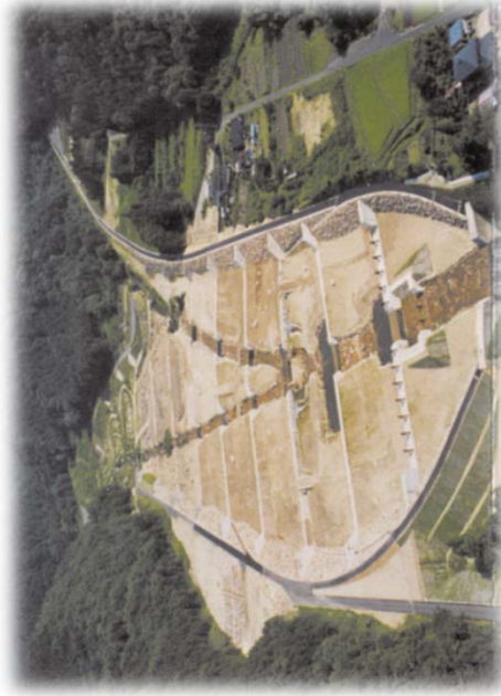
四ツ目川遊砂工
