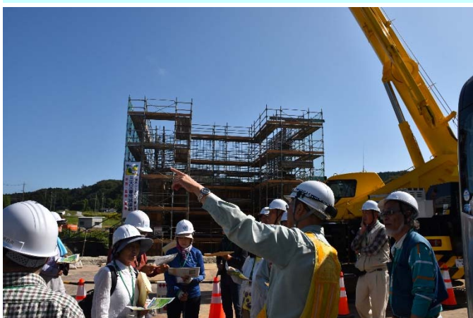
道路工事現場見学(瑞浪恵那道路)
