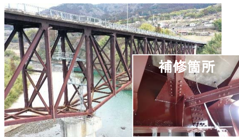
修繕代行事業(橋梁補修工事)
