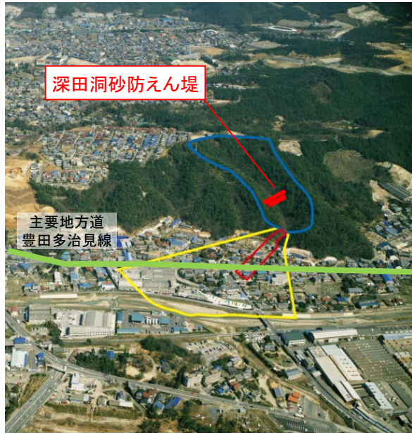
3.深田洞砂防堰堤(多治見市)
