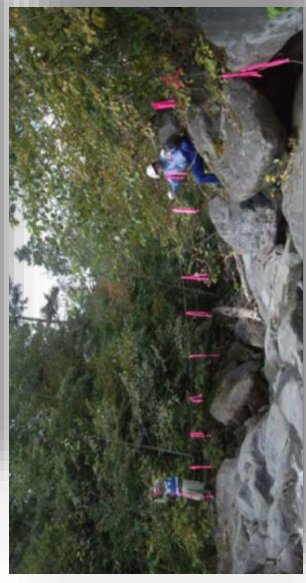
ワイヤーセンサー設置の状況
