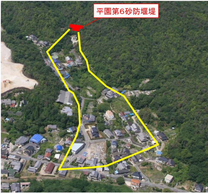
2.平園第6砂防堰堤(多治見市)
