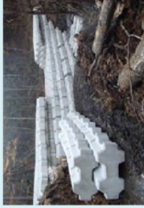
コンクリートブロック積み砂防堰堤 (鹿ノ瀬川、国土交通省中部地方整備局)
