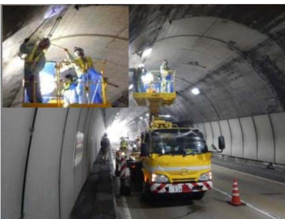
トンネル点検(高所作業車)
