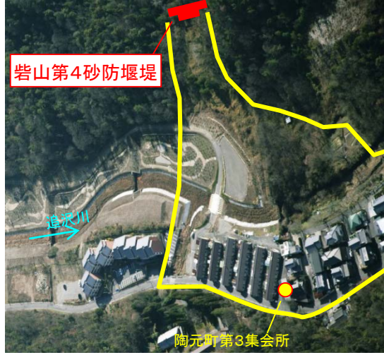
8-1.岩山第4砂防堰堤(改築)(土岐市)
