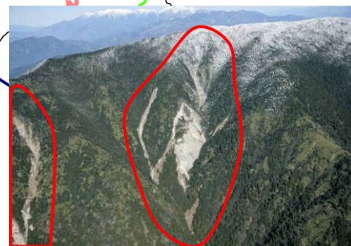
中津川(一ノ沢上流)の荒廃状況
