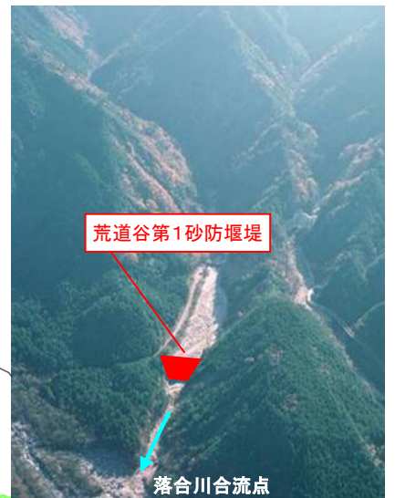
9.荒道谷第1砂防堰堤(改築) (中津川市)
