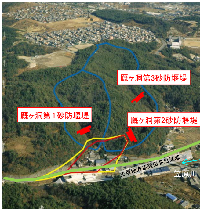
4.厩ヶ洞砂防堰堤工群(多治見市)
