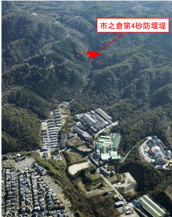
8-2.市之倉第4砂防堰堤改築(改築)(多治見市)
