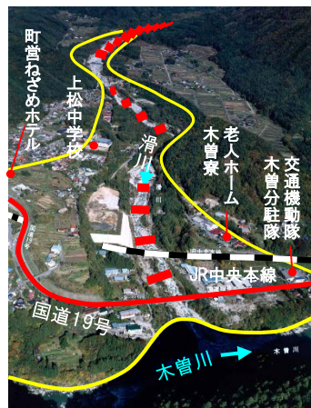
5.滑川下流床固工群(上松町)
