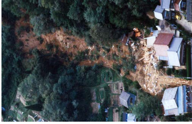
崩壊した斜面 （土岐市西山）
