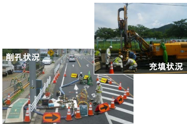
亜炭坑充填工事の様子
