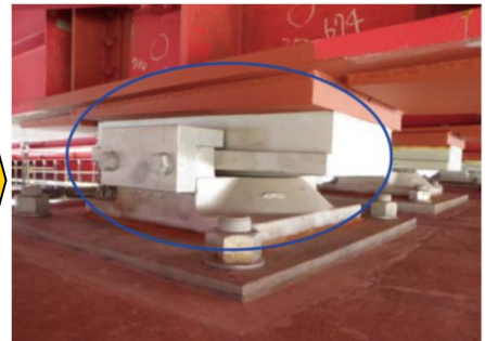
損傷部位の補修
