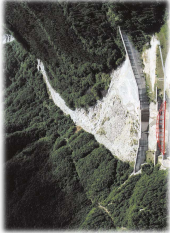
湍川第1砂防堰堤
