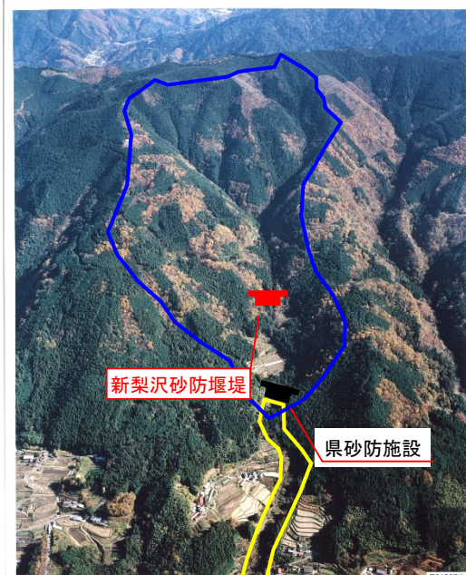
8.新梨沢砂防堰堤(中津川市)
