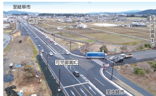
4車線化完成状況(H30.3)
