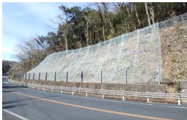
落石防止網工
