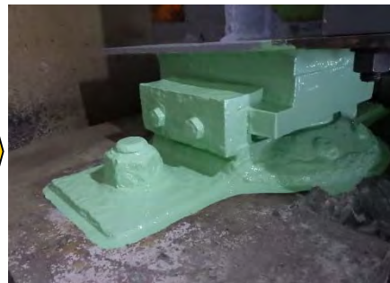
損傷部位の補修
