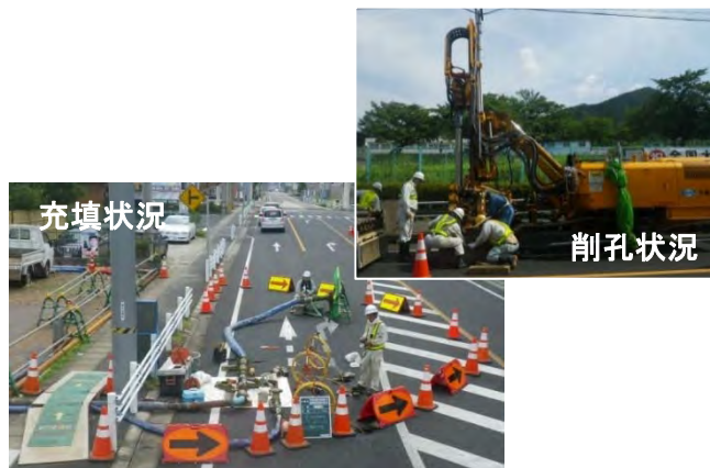
亜炭坑充填工事の様子
