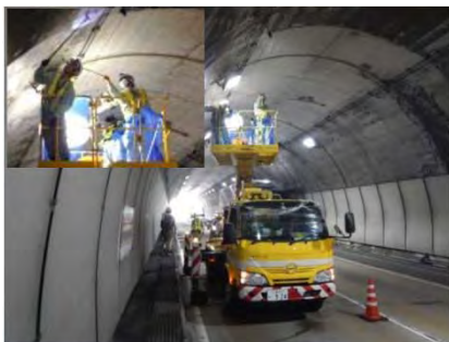
トンネル点検（高所作業車）
