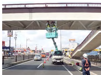
歩道橋点検（高所作業車）
