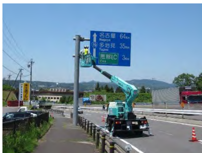
標識点検（高所作業車）
