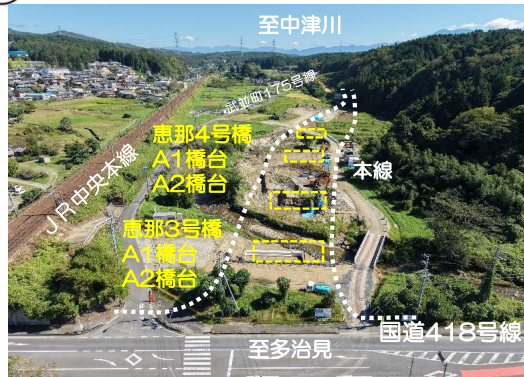
R7.恵那地区橋梁下部工事
