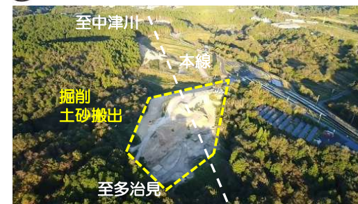
R7.早曾洞地区道路建設工事
