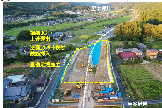
R8.名滝地区東部道路建設工事
