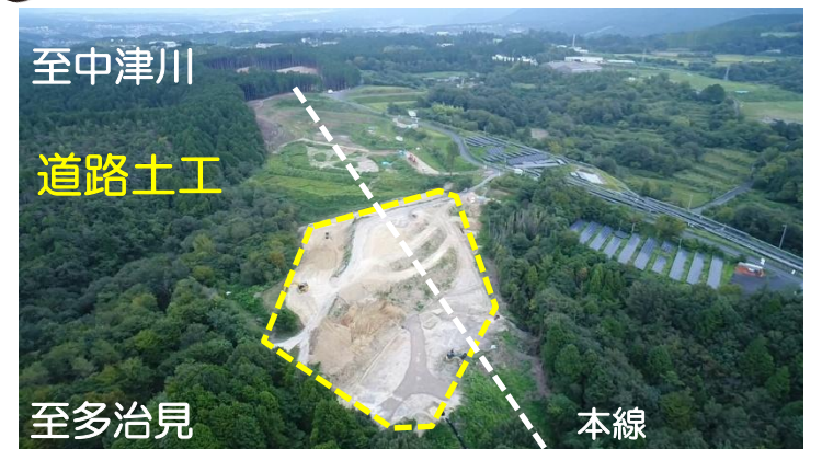
R7.瑞浪恵那道路建設工事
