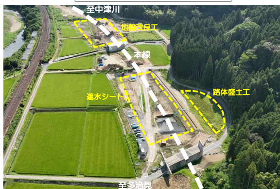
R7.公文垣内地区整備工事
