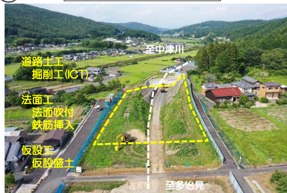
R8.名滝地区東部道路建設工事
