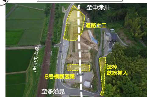
R7.町屋地区道路建設工事
