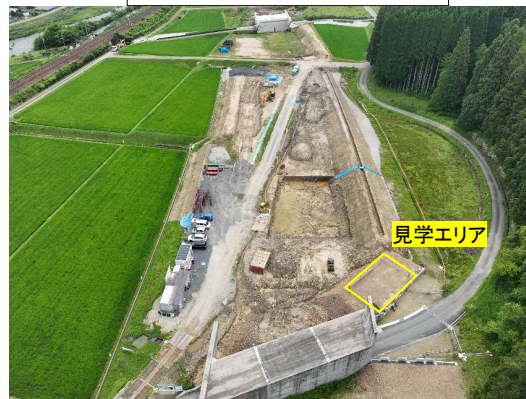
R7.公文垣内地区道路建設工事
