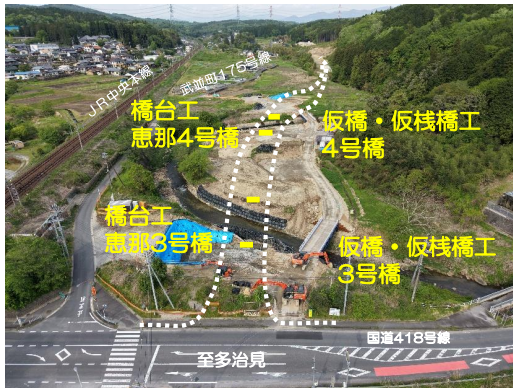
R7.恵那地区橋梁下部工事
