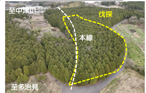
R7.早曾洞地区道路建設工事
