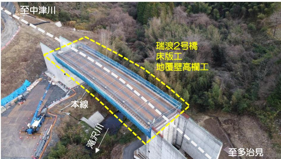
現在、瑞浪2号橋地覆壁高欄工の鉄筋・型枠工の施工を行っています。
