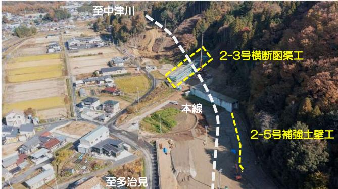
現在、2-3号横断函渠工・2-5号補強土壁工を施工しています。
