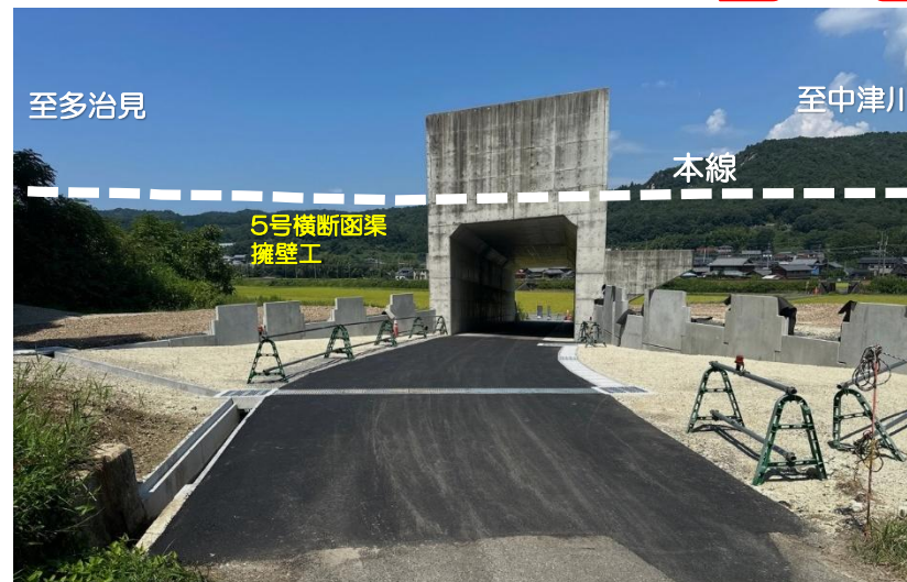
瑞浪地区道路建設工事
