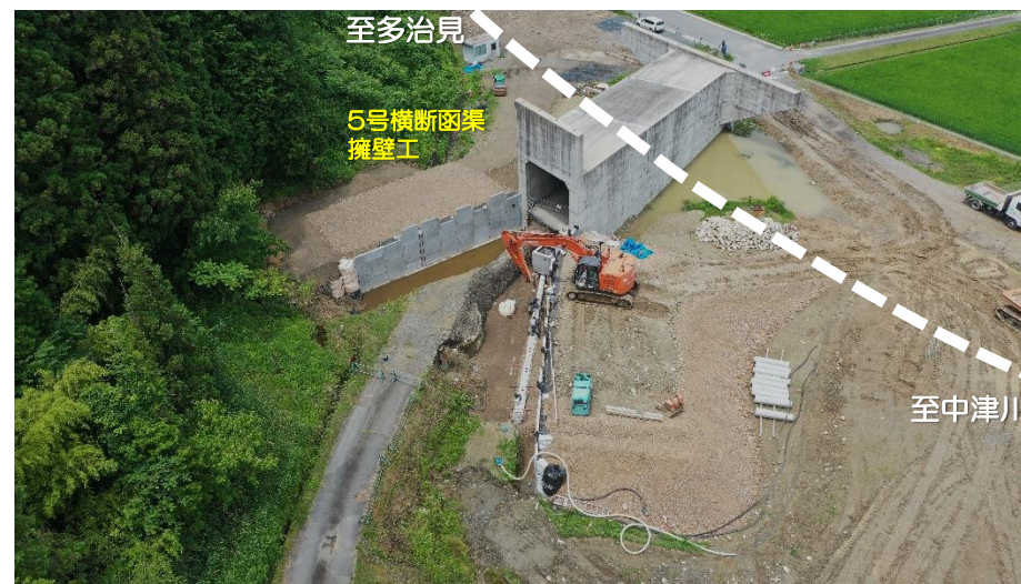
瑞浪地区道路建設工事
