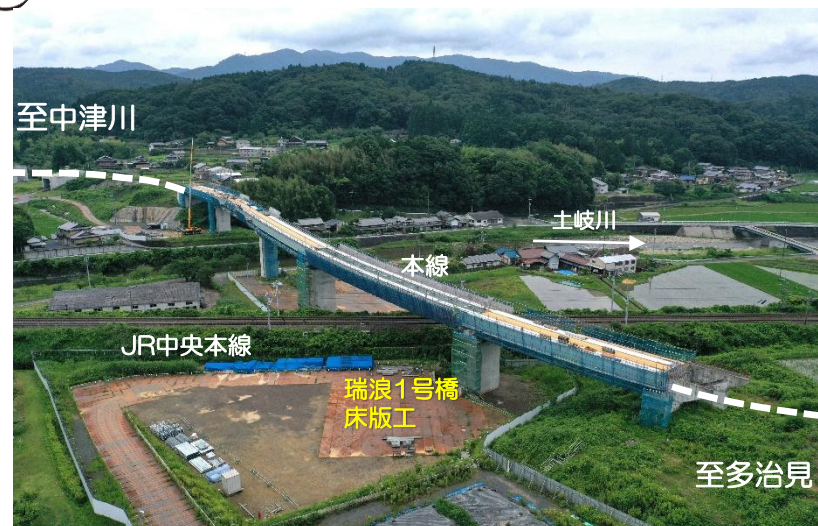
瑞浪1号橋床版工事
