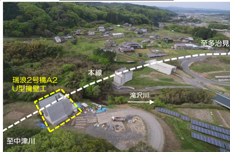
下沢地区道路建設工事
