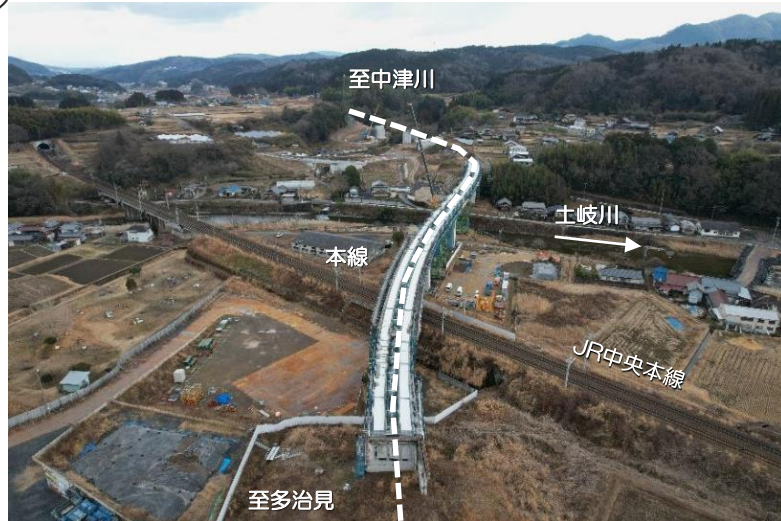
瑞浪1号橋鋼上部工事
