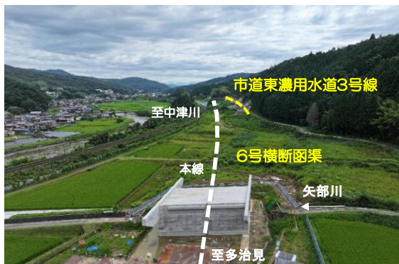
上切地区道路建設工事
