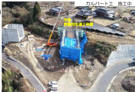
⑤ R3. 名滝地区道路建設工事
