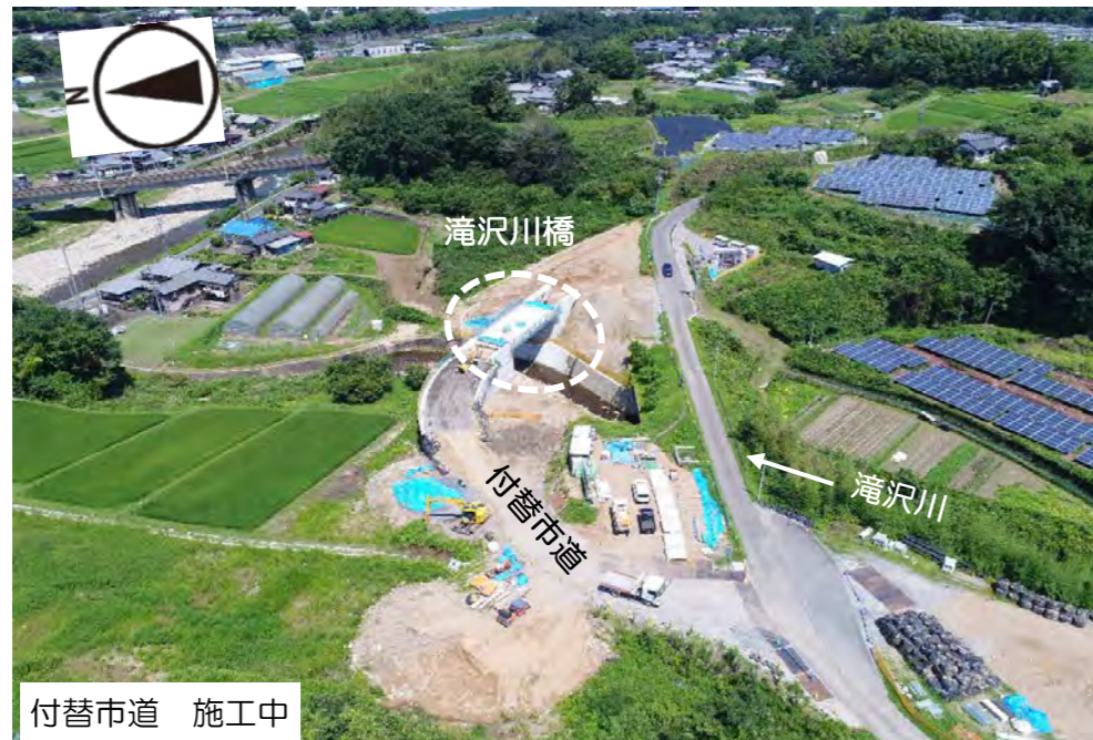
③ H31.整備工事
