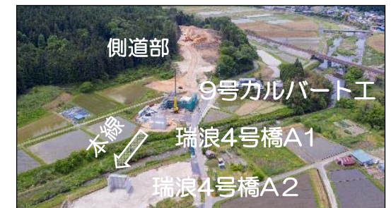
工事進捗(最新)
