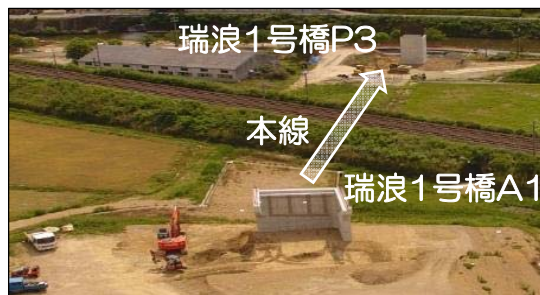
工事進捗(最新)
