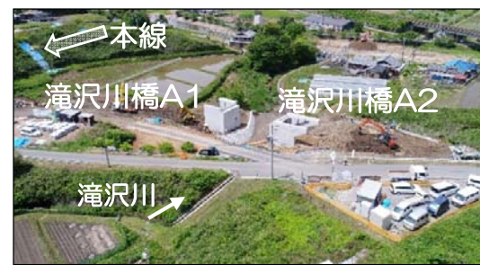
工事進捗(最新)
