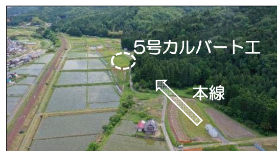
工事進捗(最新)
