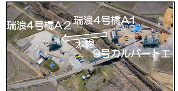
工事進捗(最新)
