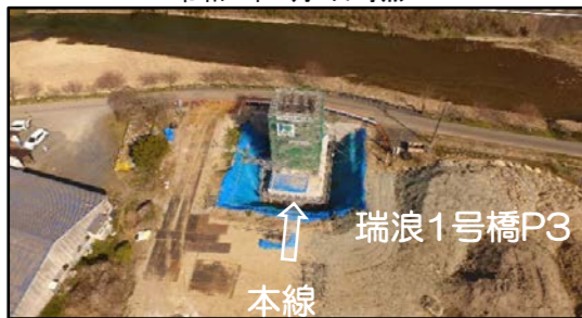
工事進捗(最新)
