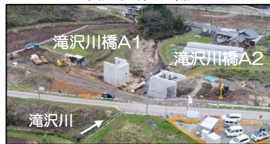
工事進捗(最新)
