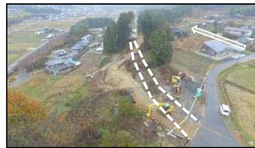
工事進捗(最新)
