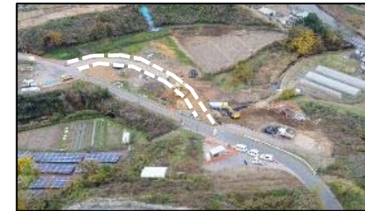
工事進捗(最新)
