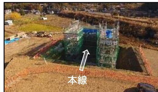
工事進捗(最新)
