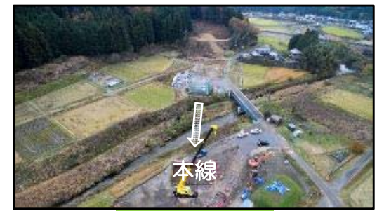
工事進捗(最新)
