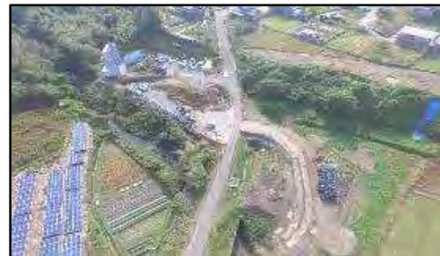
工事進捗(最新)
