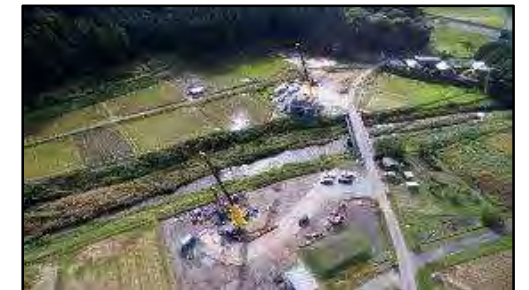
工事進捗(最新)
