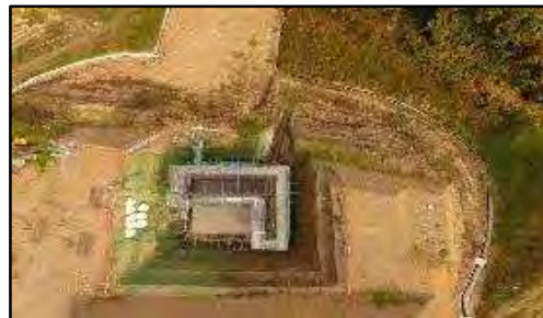
工事進捗(最新)
