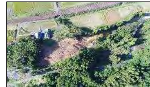
工事進捗(最新)
