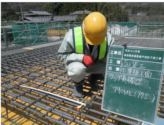
鉄筋の組み方確認
