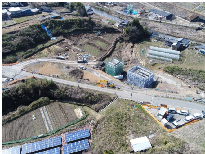
橋台および工事用道路の工事中
