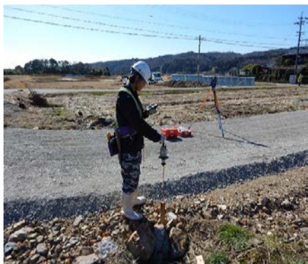
自動追尾にて測量を行っている状況
