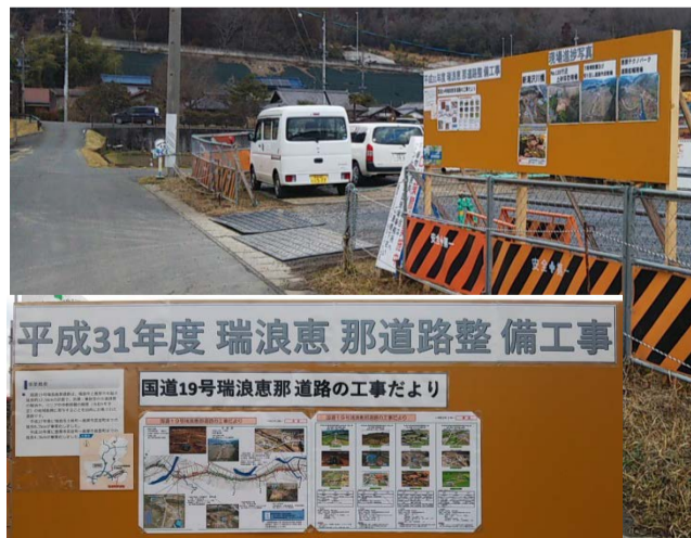
地域への工事現場PR掲示板
