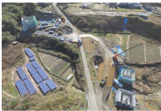
橋台および工事用道路の工事の様子
