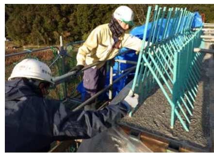
組立後の鉄筋の確認
