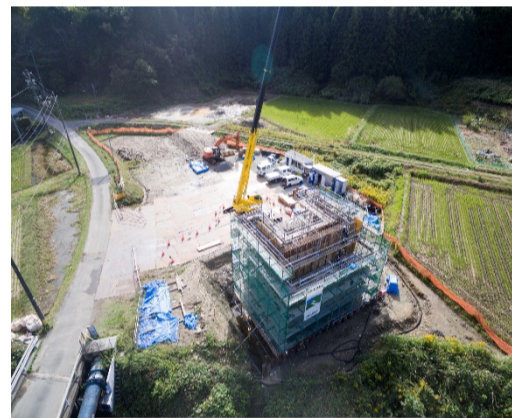
佐々良木川の両岸で橋台を造っています
