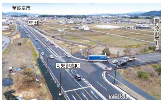
4車線化完成状況(H30.3)
