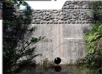
上原第1砂防堰堤
