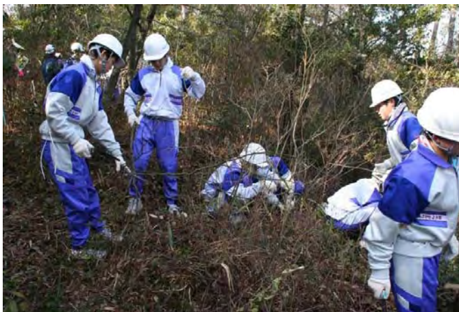
歩道整備作業
