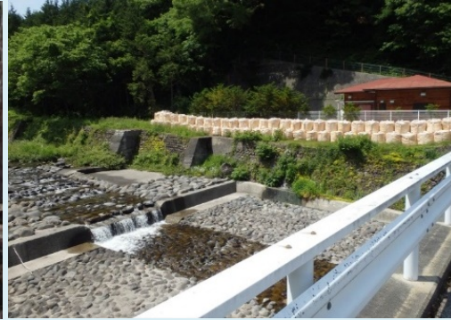
大型土のうによる護岸の嵩上げ (鈴ヶ沢、長野県)
