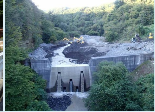
砂防堰堤の除石 (湯川、長野県)
