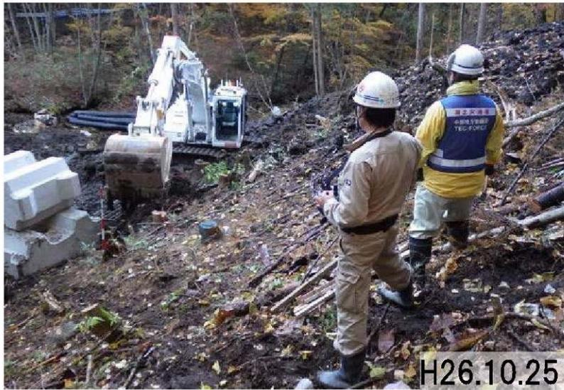
図 8.6.1 遠隔操作無人化施工のバックホウ（平成 28 年噴火時 鹿ノ瀬川）
