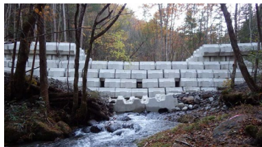
砂防えん堤を設置
