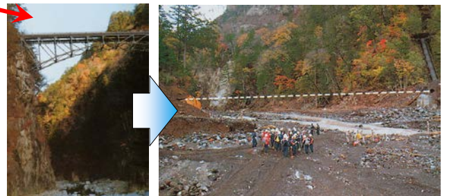
② 王滝川にかかる関西電力の導水管地点の地形変化 (長野県西部地震の記録編集委員会, 1986; 餓鬼ヶ咽(がきがのど)付近)
