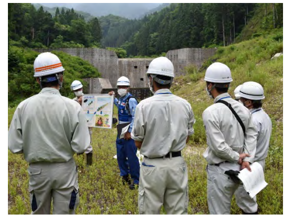
砂防施設点検の説明 (6/21 南木曾町:梨子沢第3砂防堰堤)
