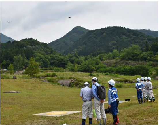
ドローンを用いた点検 (6/20 中津川市:四ツ目川遊砂工)
