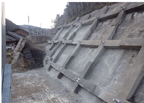
のりわくこう いびぐんいびがわ 法枠工（揖斐郡揖斐川町）
