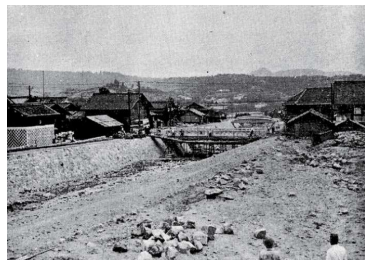
復興改修が進む四ツ目川流路 (災害直後)
