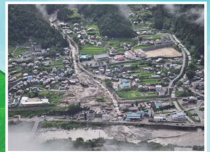
梨子沢土石流 (2014年7月) (長野県木曾郡南木曾町)
