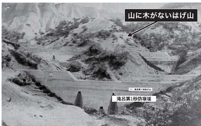
滝呂第1砂防堰堤 (多治見市)
