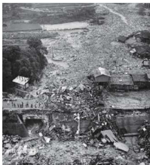
おおさわ ど さわ ど しゃ じょうきょう き そ ぐん な ぎ そ まち 大沢田沢の土砂流出状況 (木曽郡南木曽町)
