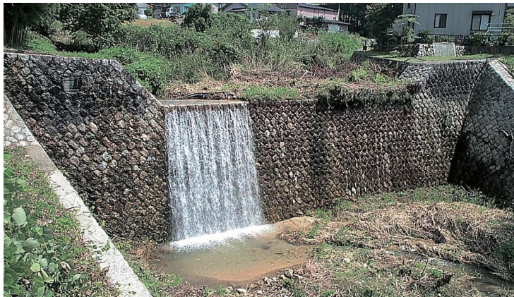
山神砂防堰堤（中津川市）
