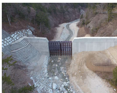
越百川第3砂防堰堤 (長野県木曽郡大桑村)
