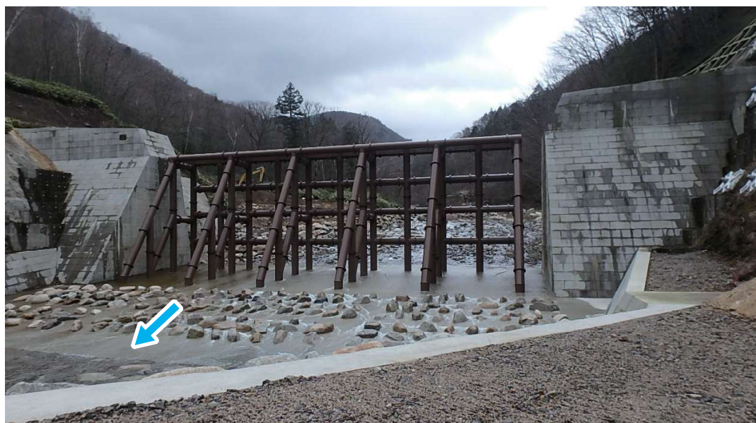
なか つか わ さ ぼう えん てい なか つか わ 中津川第 11 砂防堰堤 (中津川市)
