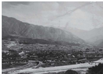
改修整備された中津川、四ツ目川護岸堤 (昭和15年(1940年)頃)
