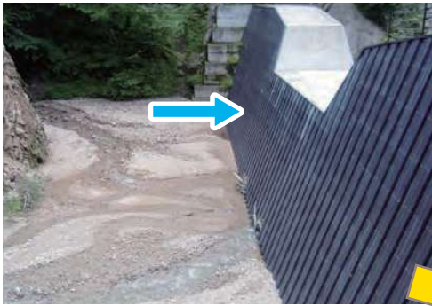
さ ほう えん てい 土石流が発生する前の砂防堰堤（上流側）
