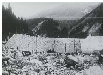
復興が進む四ツ目川と建設が進む砂防堰堤
