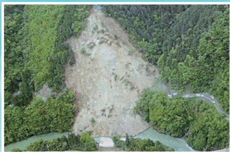
2006年5月発生 (岐阜県揖斐郡揖斐川町)
