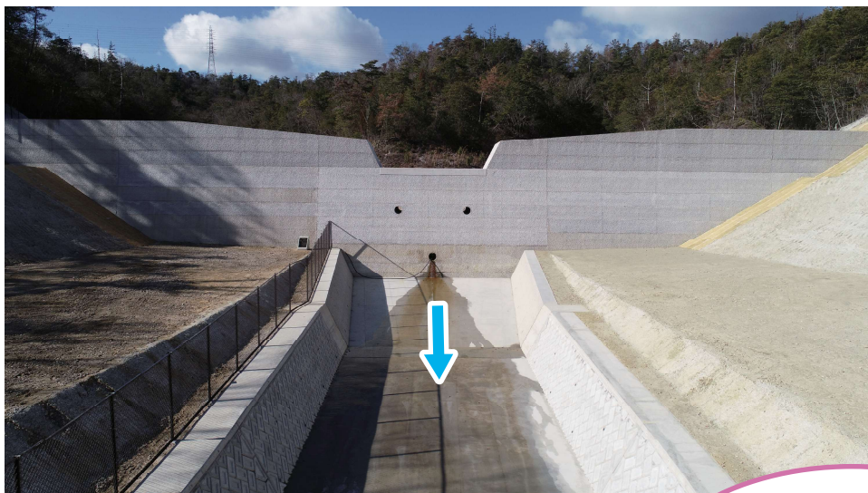
平園第6砂防堰堤（多治見市）
