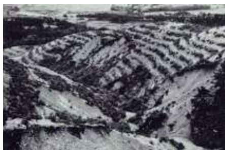
山腹工 施工後 (昭和30年代 1955年頃)
