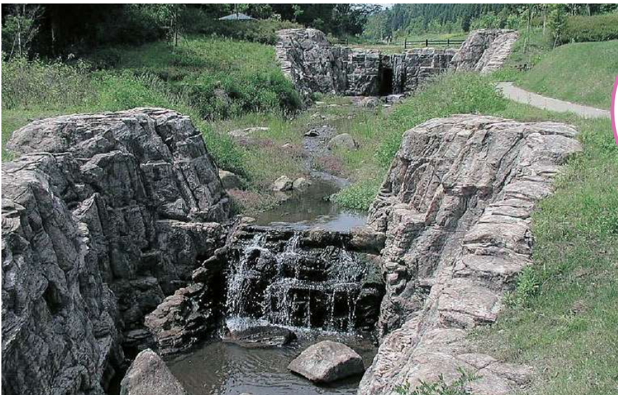
雲五川床固工群 (土岐市)
