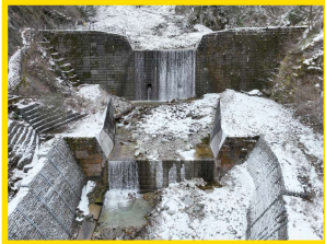
本谷第10砂防堰堤 (中津川市)
