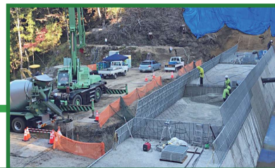
堰堤にコンクリートを流し入れるよ！
