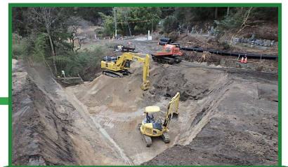
土を掘って堰堤の場所を整えるよ！
