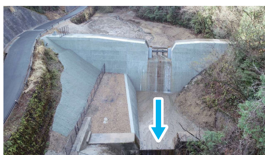
いち の くら さ ぼう えん てい た じ み 市之倉第 3 砂防堰堤 (多治見市)
