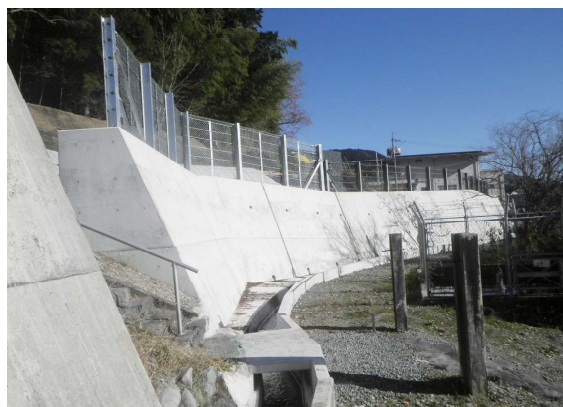
ようへきこう なかつがわ 擁壁工（中津川市）
