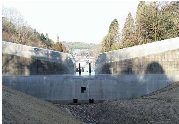
水道川第2砂防堰堤（土岐市）
