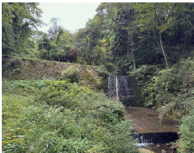
浦山第2砂防堰堤（土岐市）
