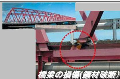
橋梁の損傷(鋼材破断)
