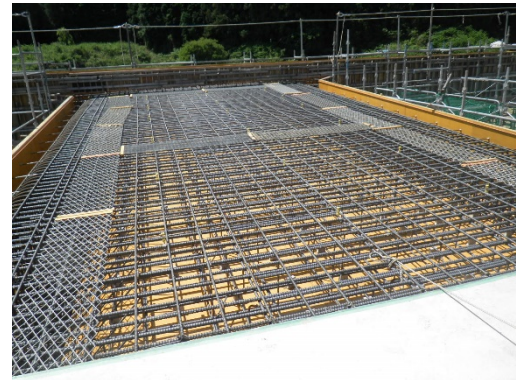
整然と組みあがった鉄筋
