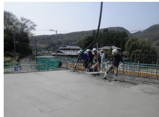
コンクリートを打ち込む様子
