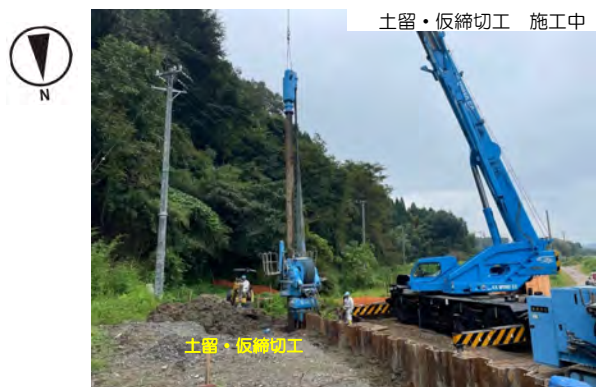
③ R3.中畑道路建設工事
