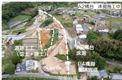
A2橋台の躯体と道路土工の切土盛土を施工しています。
