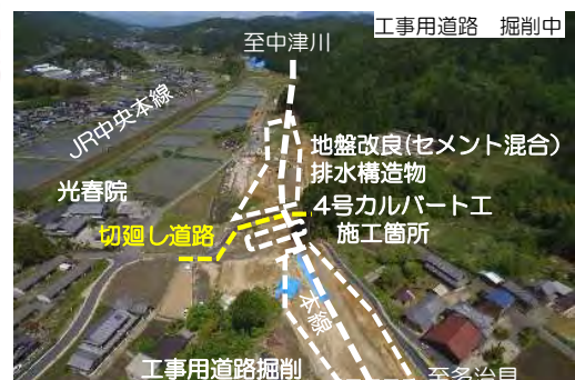
工事用道路の掘削・地盤改良を施工しています。
