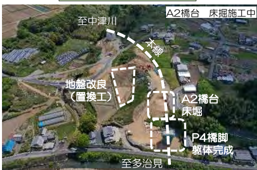
A2橋台の床掘・地盤改良を施工しています。
