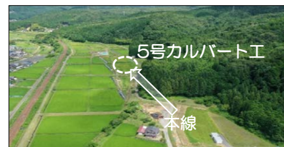
工事進捗(最新)
