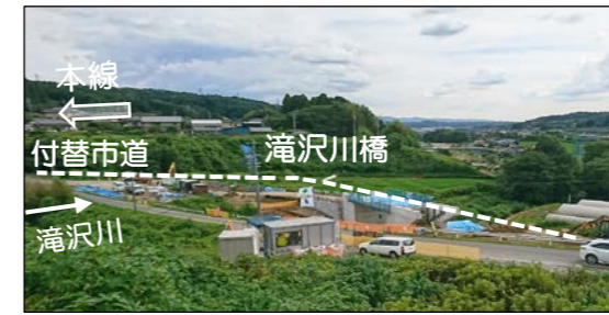
工事進捗(最新)
