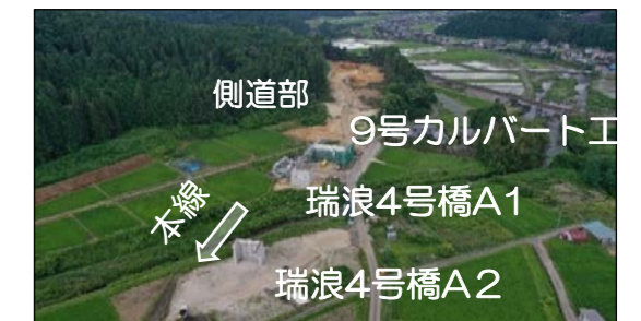
工事進捗(最新)
