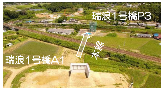
工事進捗(最新)
