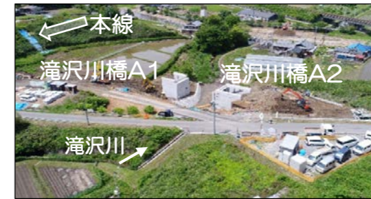
工事進捗(最新)
