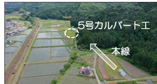
工事進捗(最新)
