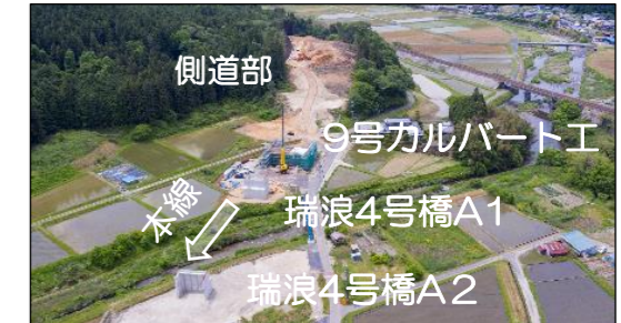
工事進捗(最新)
