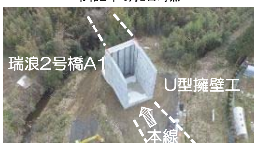
工事進捗(最新)
