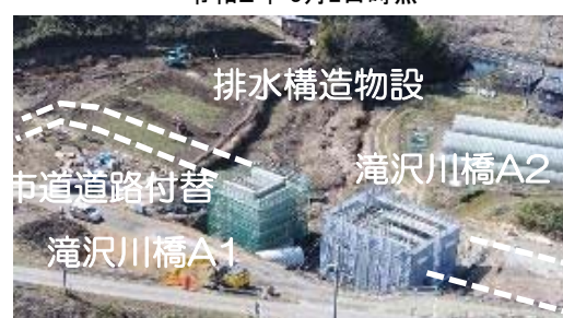
工事進捗(最新)
