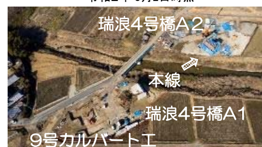
工事進捗(最新)
