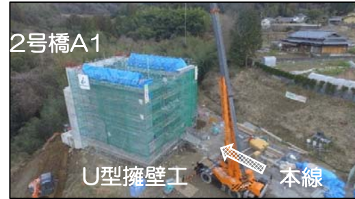
工事進捗(最新)
