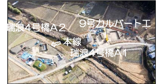
工事進捗(最新)
