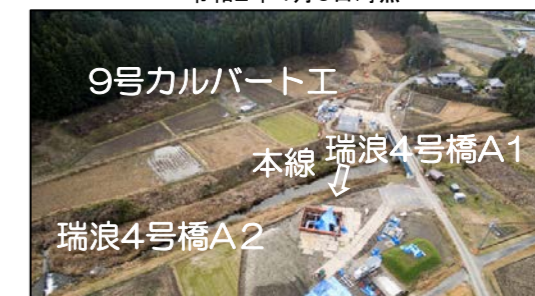
工事進捗(最新)
