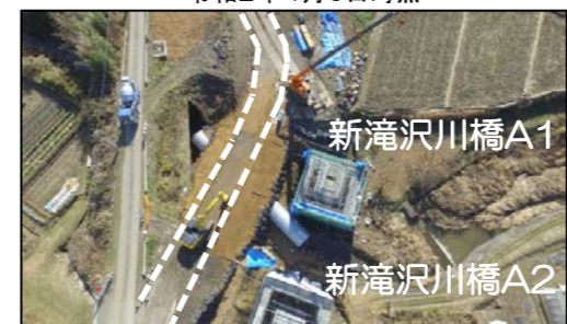
工事進捗(最新)
